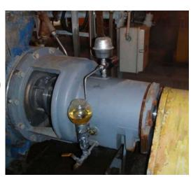
Las cámaras de expansión ecualizadoras están diseñadas para evitar aumentos de presión en los sistemas cerrados. Un diafragma rodante proporciona un volumen variable, que cuando se dimensiona adecuadamente, mantiene la presión de la caja reductora en cero o cerca de cero PSI. La presión reducida extenderá la vida útil de los sellos, empaques y ayudará a evitar fugas.
